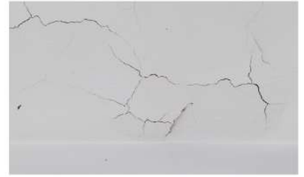
ฉาบเพดาน ท้องพื้นคอนกรีต
